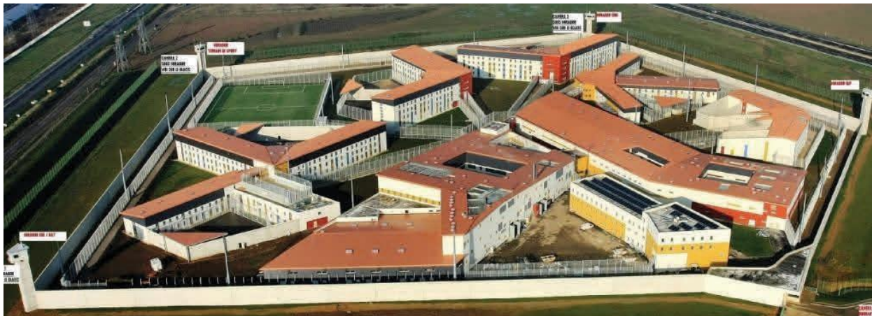
Centre pénitentiaire Sud francilien
