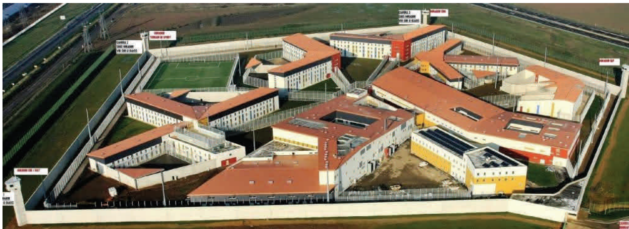
Centre pénitentiaire Sud francilien
